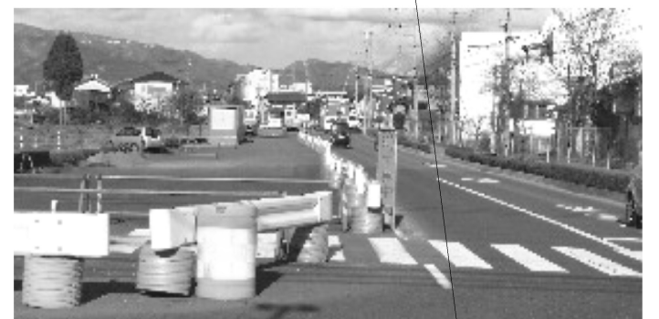
◎3・3・1環状線（栄町工区）
