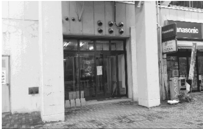
全館閉鎖建物調査に伴ってグリーンベル21の駐車場棟の1階へ移転したFMOZE
