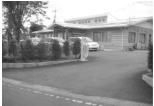
スプリンクラー設置予定の白沢町こごぶの家
